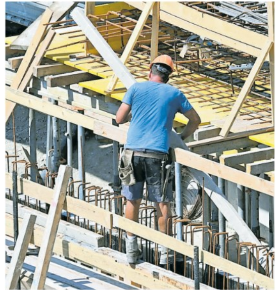
Un operaio edile al lavoro in un cantiere ANSA
